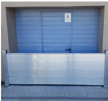
Bild: Exempel på demonterbart/semipermanent översvämningsskydd. Källa: Hydratec.
