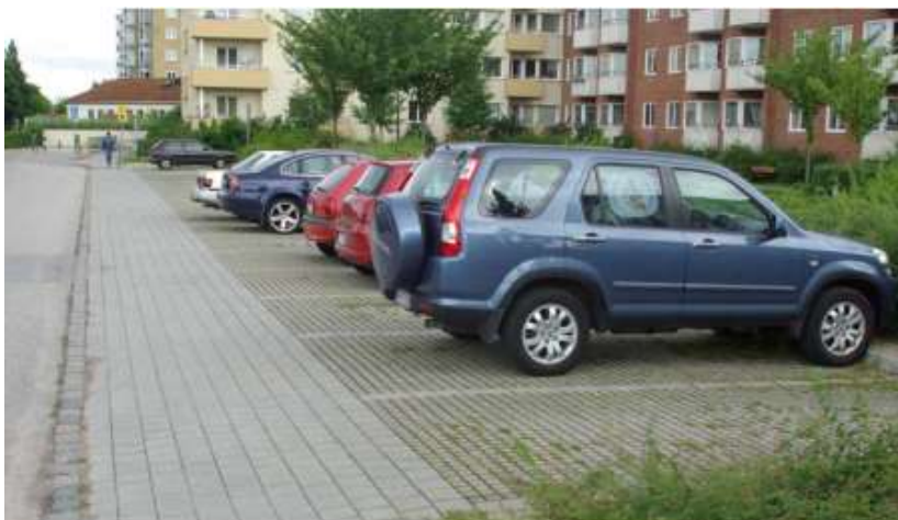
Figur 19. Gräsarmerande betongbeläggning. WRS se Stockholm Vatten och Avfall
