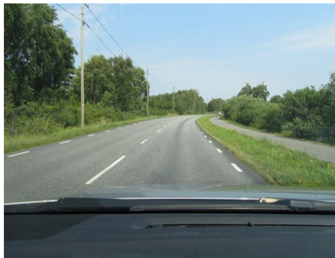
Figur 14. Skarviksvägen med separat gång- och cykelväg.
