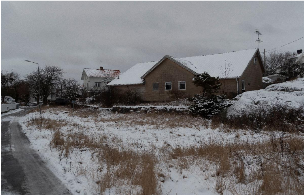
Fasad mot väster. Ett av de tre fönstren är igensatt.
