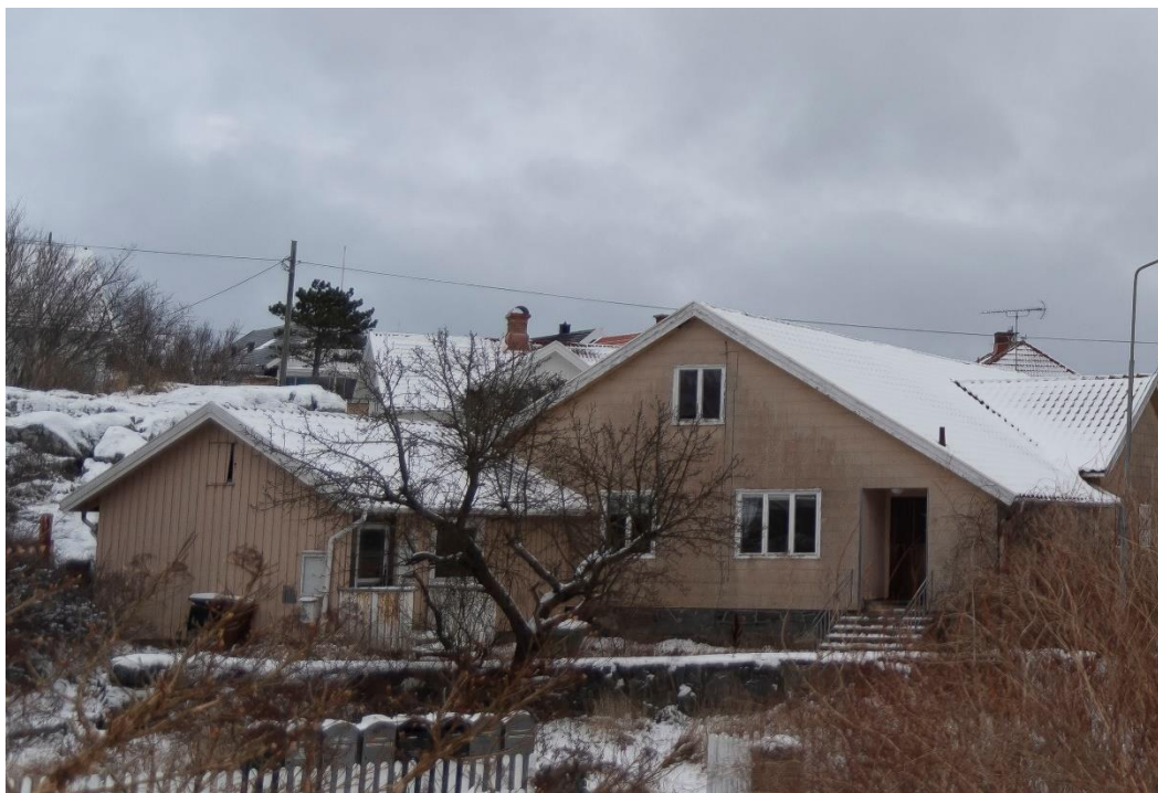
Foto mot norrsida fasad och den lägre tillbyggnaden.
