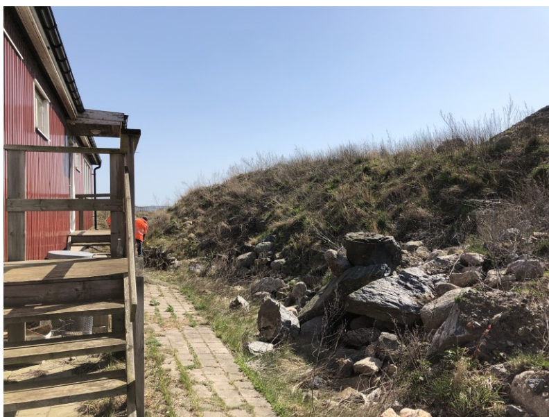
Bild 4. Invallning av upplagsyta.
